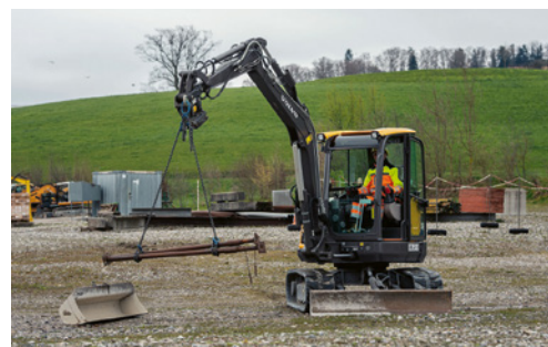
6 La charge transportée avec la pelle mécanique est correctement élinguée.
