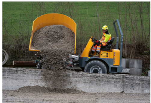
3 Afin d'empêcher le basculement des engins de chantier, la zone de déversement est bordée d'une protection anti-franchissement (au moins un tiers de la hauteur des roues).
