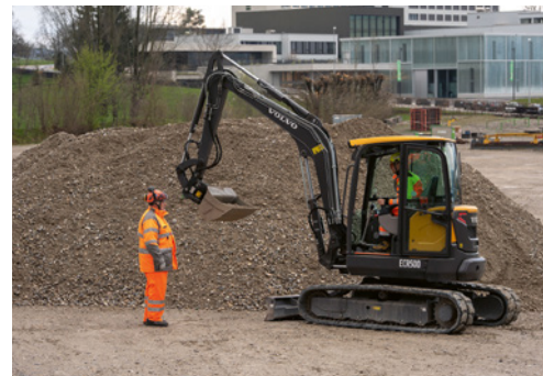
7 La personne présente dans la zone de travail est en contact visuel avec le conducteur de l'engin de chantier.
