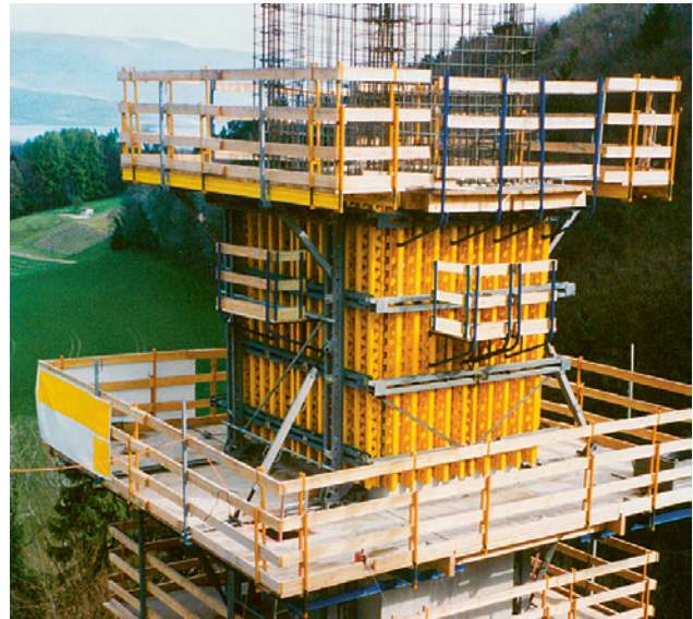
6 Sicheres Arbeiten auf einer Kletterschalung mit Nachlaufbühnen
