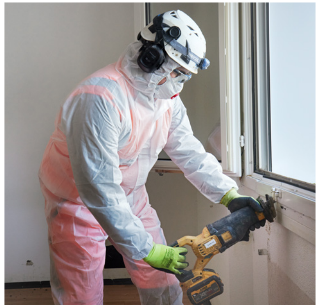
1 aglio del telaio della finestra con una sega a gattuccio
