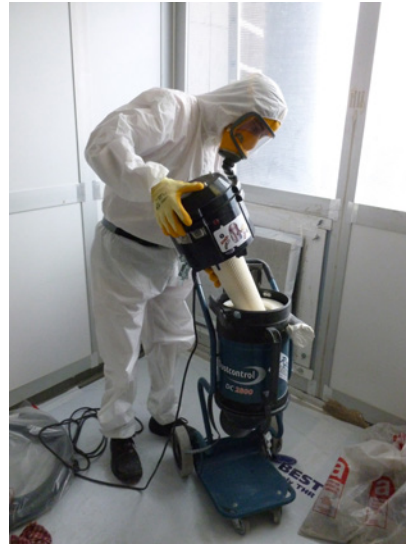
5 Controllo periodico e manutenzione dell'apparecchio all'interno di una zona confinata da parte di una ditta specializzata in bonifiche da amianto
