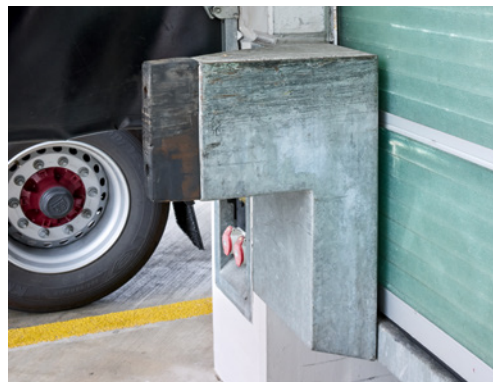
1 Attenzione: pericolo di schiacciamento! Distanza minima di sicurezza tra muro e autocarro 0,4 m
