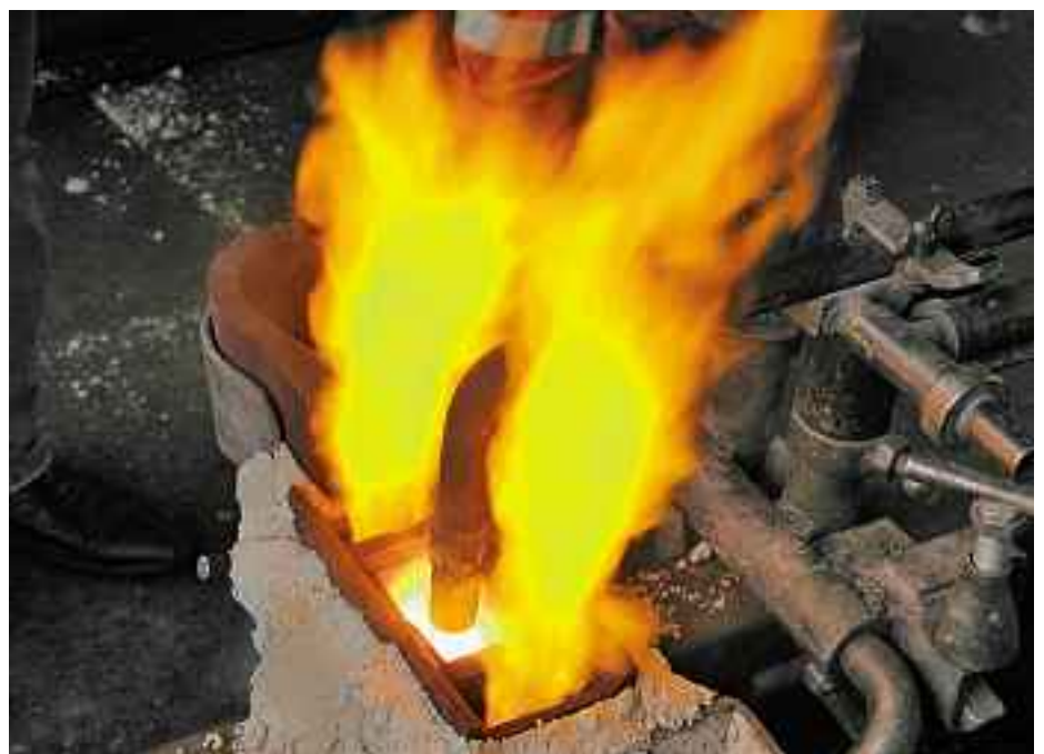
Bild 1: Schweißen von Eisenbahnschienen mit dem Thermitschweißverfahren
