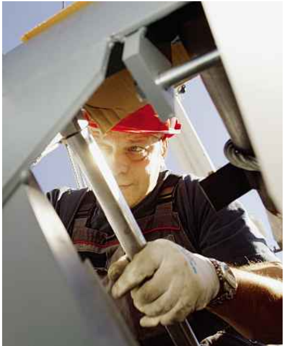
Wichtig bei der Instandhaltung: planmässiges Arbeiten und anschliessende Kontrolle.
