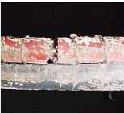
Bild 6: Defekte Schweissanlage, entdeckt bei einer Inspektion.
