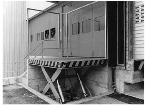
1 Lorsque la plateforme est abaissée, le garde-corps forme une barrière de 1 m au niveau du quai supérieur.
