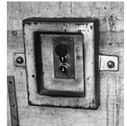
4 La commande, encastrée dans le mur ou entourée d'un cadre robuste, est protégée des chocs dus aux véhicules.
