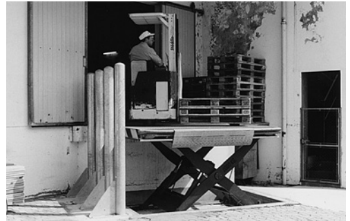
2 Ces piliers ont été installés après la chute d'un cariste avec son gerbeur depuis la plateforme.
