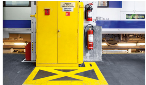
2 Marquage en jaune d'une zone à maintenir dégagée.
