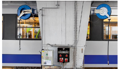
1 Un distributeur de câbles apporte de l'ordre et élimine les risques de chute.
