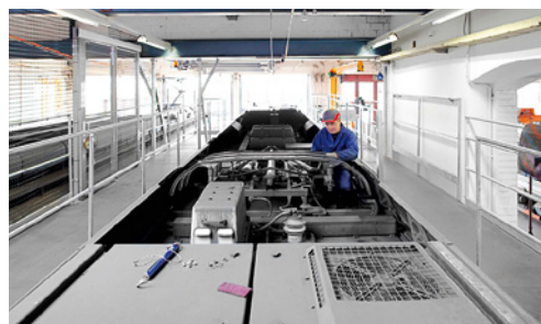
8 Travaux sur le pantographe sur le toit du véhicule: la passerelle est équipée de garde-corps amovibles.
