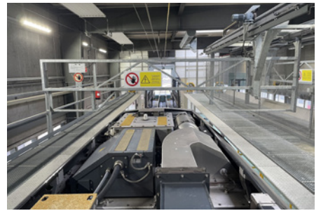
10 Protection contre les chutes au niveau de la face frontale.
