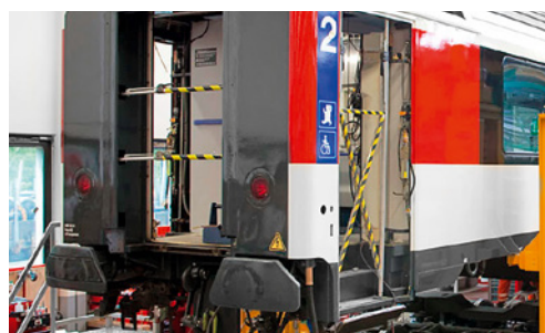
7 Barres de sécurité contre les chutes.
