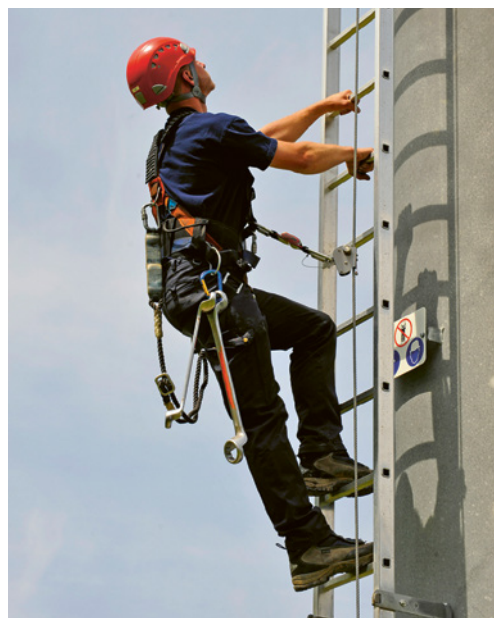
4 Steigschutzeinrichtung mit Falldämpfer.
