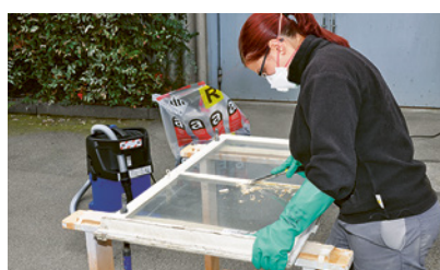
2 Misure di protezione nella rimozione di stucco per finestre contenente amianto
