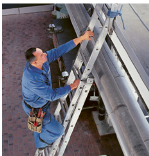
1 Scala portatile semplice messa in sicurezza contro lo scivolamento
