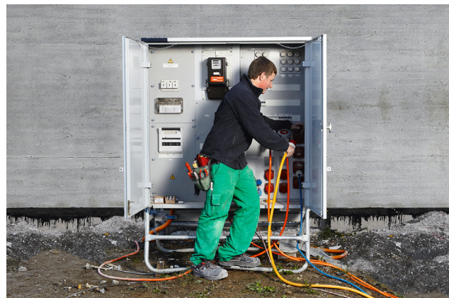
1 Elektrikmonteur beim Erstellen eines Bauprovisoriums
