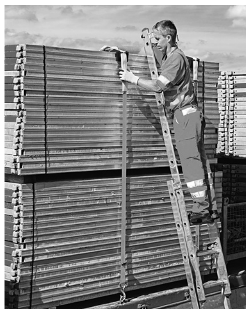
3 Échelle utilisée pour l'élingage des charges en hauteur.
