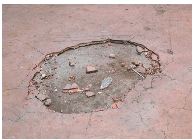
1 Steinholz-Bodenbelag – asbesthaltiger Magnesia-Estrich
