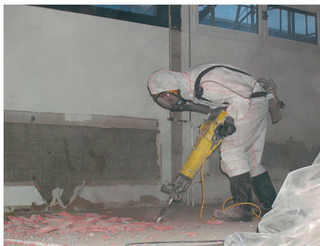
2 Ein Bodenbelag wird mit einem Spitzhammer entfernt.
