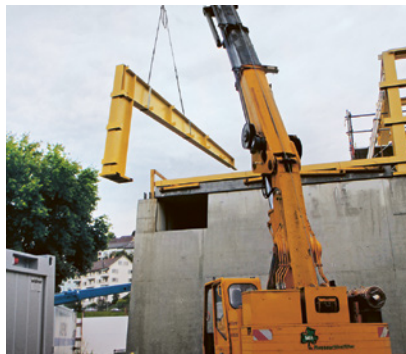
2 Imbracare correttamente i carichi asimmetrici.
