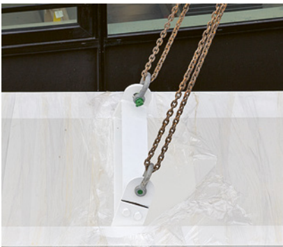
1 Montare i punti di ancoraggio nelle posizioni predefinite.
