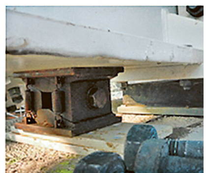
3 Cautela in presenza di appoggi temporanei: evitare il ribaltamento delle travi!
