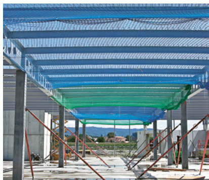
1 Predisporre per prima cosa i dispositivi di protezione collettiva (ad es. montare le reti di sicurezza).
