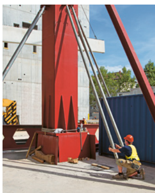
Regola 7 Stabilizzare gli elementi di costruzione già posizionati
