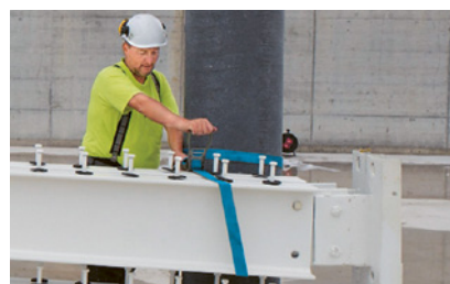
3 Mettere in sicurezza gli elementi di costruzione contro il ribaltamento.
