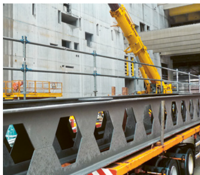
2 Preassemblare la protezione laterale già in fabbrica oppure sul luogo di scarico.
