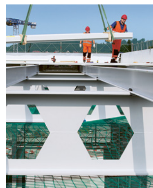
Regola 8 Per i lavori in altezza usare una protezione collettiva
