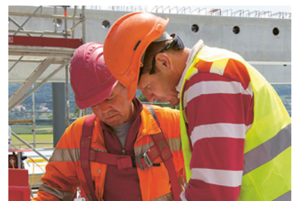
3 Discutere all'interno del team lo svolgimento dei lavori.
