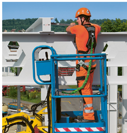
2 Lavoro di montaggio con piattaforma di lavoro elevabile: efficiente, sicuro ed ergonomico.
