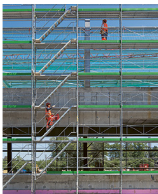
Regola 9 Creare luoghi di lavoro e accessi sicuri
