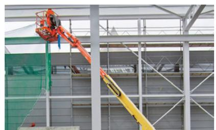
3 Utiliser des plateformes élévatrices mobiles de personnel au lieu d'une protection par encordement.
