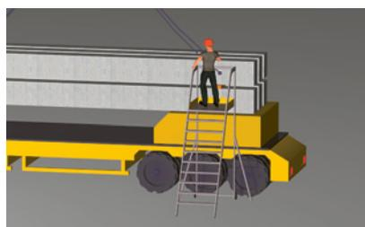
2 Utiliser des outils, de longues élingues ou une protection par encordement pour arrimer/désarrimer la charge à partir d'une hauteur de chute de 2,0 m.
