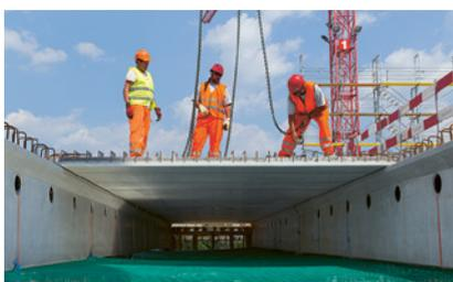
1 Recourir dans un premier temps aux mesures de protection collective (par ex. monter des filets de sécurité).
