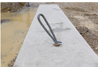
1 Monter les points d'ancrage aux endroits définis au préalable.
