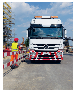
Règle 4 Sécuriser les zones de déchargement et de stockage.
