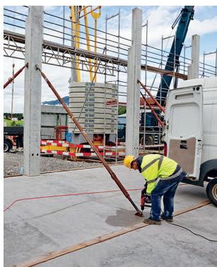
Règle 7 Stabiliser les parties de construction.
