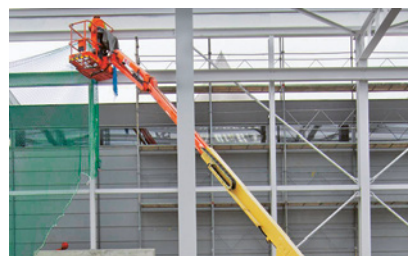
3 Utiliser des plateformes élévatrices mobiles de personnel au lieu d'une protection par encordement.
