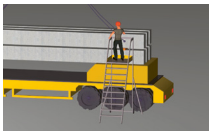
2 Utiliser des outils, de longues élingues ou une protection par encordement pour arrimer/désarrimer la charge à partir d'une hauteur de chute de 2,0 m.
