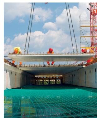
Règle 8 Installer des protections collectives.
