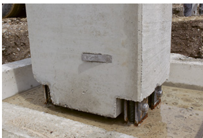
1 Embase correctement sécurisée avec quatre ancrages.
