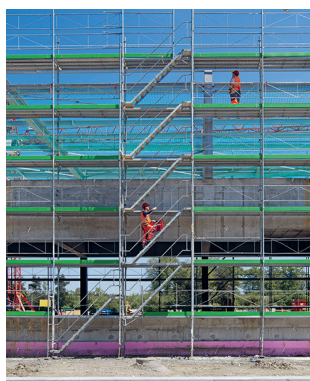
Règle 9 Installer des accès et des postes de travail sûrs.
