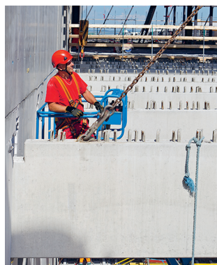
Règle 2 Utiliser les points d'arrimage prévus.
