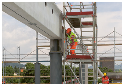
2 Travaux de montage avec une tour d'échafaudages: efficace, sûr et ergonomique.
