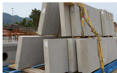
3 Sécuriser les éléments de construction contre tout risque de renversement.
