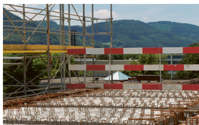
2 Garde-corps (barrières de protection)
