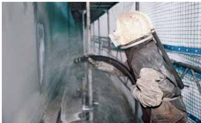
Sableur: les travailleurs occupés dans le secteur du traitement contre la corrosion sont surveillés médicalement.
