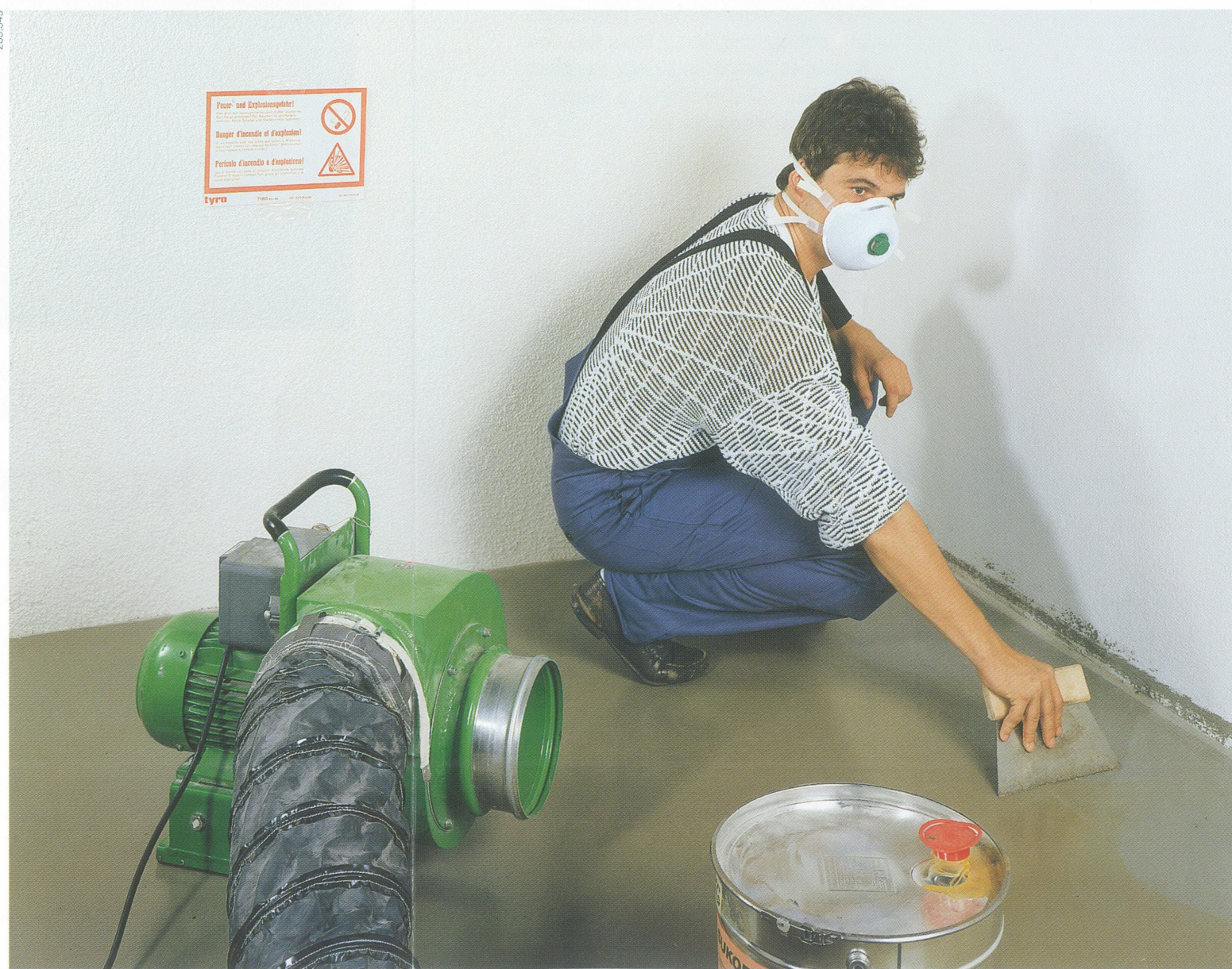
Figure 3: Le masque à filtre à charbon actif empêche la pénétration de vapeurs de solvants dans les voies respiratoires. Il doit être porté là où l'aspiration est insuffisante.
