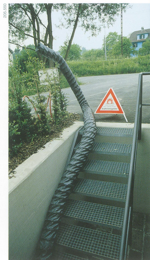
Figure 4: Zone de danger. Triangle d'avertissement et barrage, dans ce cas lors de dégagement de vapeurs de solvants à l'air libre. La zone de travail doit être barrée et signalée de la même manière.
