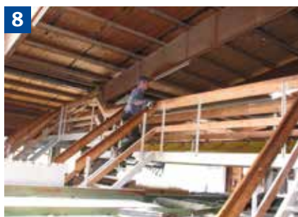
Übersteigen einer Fördereinrichtung auf einem Übergang.
