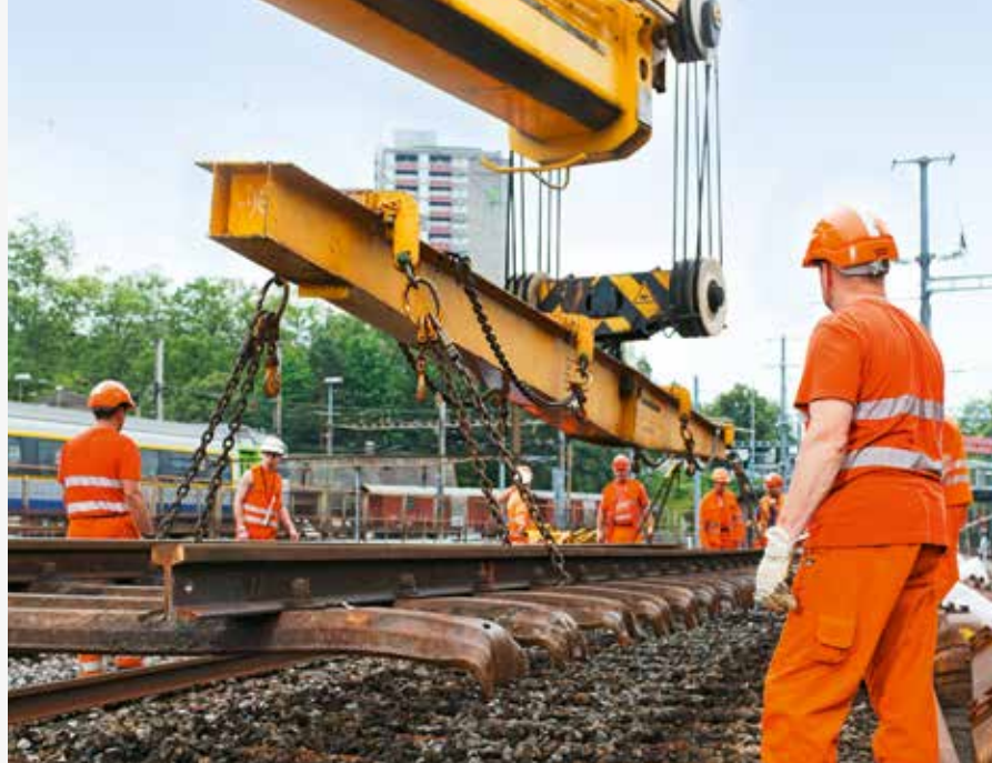
Levage d'un élément de voie.
