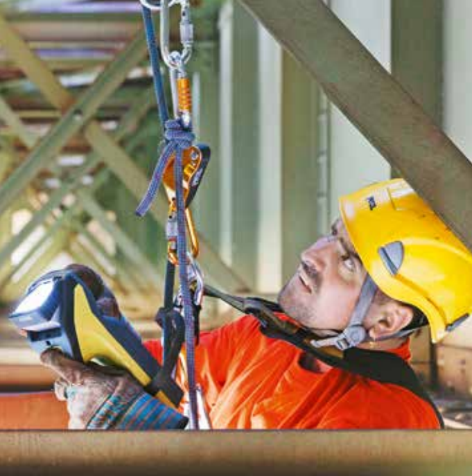
Contrôles des infrastructures sur des ponts.
