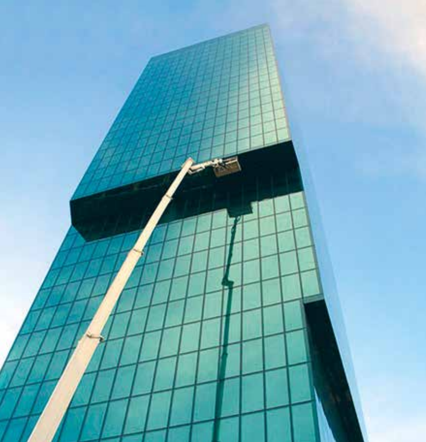
Nettoyage des vitres d'un gratte-ciel avec une plateforme de travail.
