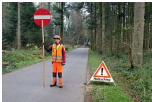
1 Luogo di lavoro segnalato nel bosco con segnaletica stradale
