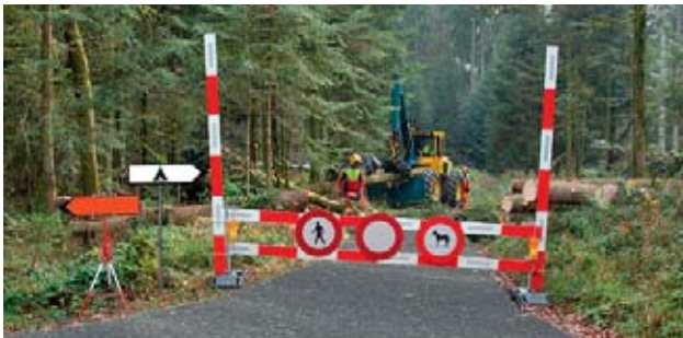
2 Esempio di strada sbarrata in un bosco; sbarramenti con barriere a strisce bianco-rosse e segnaletica per tutti gli utenti della strada
