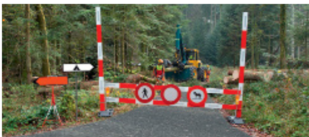
2 Esempio di sbarramento di una via di circolazione con tavole bianco/rosse e segnaletica per tutti gli utenti della strada
