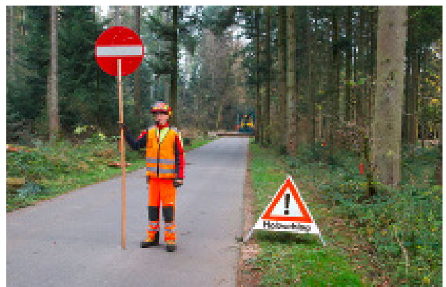
1 Posto di lavoro nel bosco con segnalazione e regolazione del traffico
