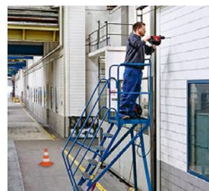
3 Plateforme de travail utilisée pour des travaux en hauteur.
