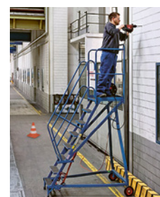
3 Plateforme de travail utilisée pour des travaux en hauteur.
