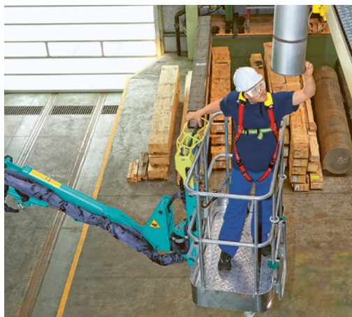
1 PEMP utilisée pour remplacer une ampoule en hauteur.
