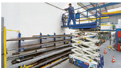
2 PEMP utilisée pour des travaux d'installation et de nettoyage en hauteur.
