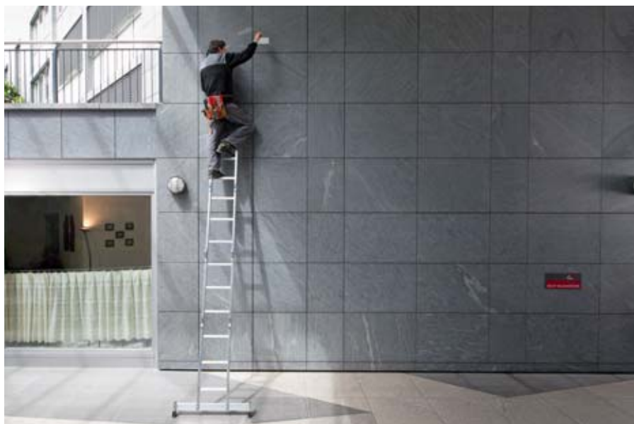
Die Leiter des Lehrlings war zu kurz für die Arbeit (nachgestellte Situation).
