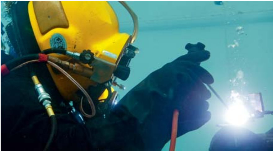
Abbildung 6b Berufstaucher beim Unterwasserschweißen. Fast alle Bau- und Montage-techniken, die über Wasser zum Einsatz kommen, können auch unter Wasser verwendet werden.
