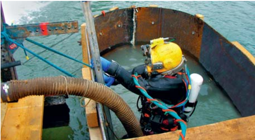
Abbildung 6c Schalwand aus Stahl für das Betonieren eines Brückenpfeilerfundamentes. Einstieg des Tauchers zur Befestigung der unter Wasser zu legenden Armierungseisen. Der Taucher wird von der Oberfläche aus schlauchversorgt. Auf dem Rücken trägt er für den Notfall eine Atemgasreserve.
