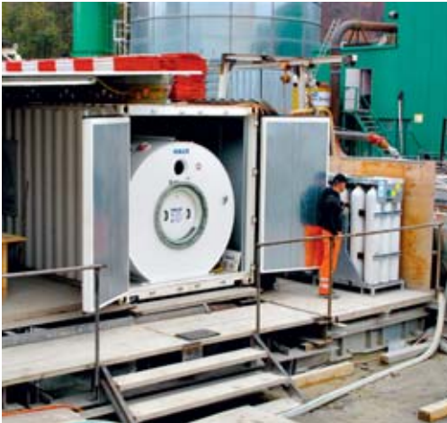
Abbildung 23a Beispiel einer in einem Container montierten Behandlungskammer auf der Baustelle.
