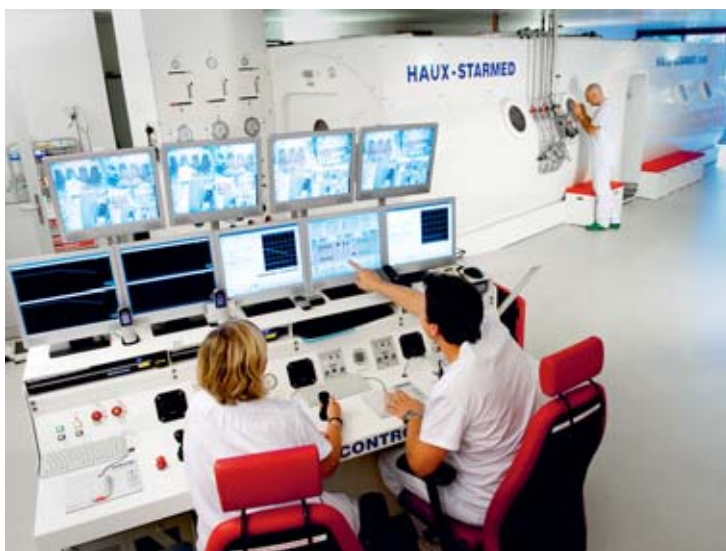
Abbildungen 24a, b Behandlungskammer im Spital, die pro Einheit 8 sitzenden oder drei sitzenden und einem liegenden Patienten zur Beatmung mit reinem Sauerstoff Platz bietet. Entsprechend ist eine aufwändige Überwachungseinheit erforderlich.
