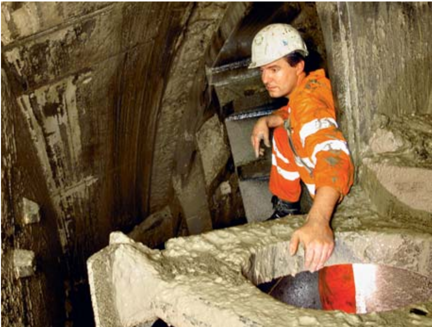
Abbildung 9c Bei abgesenktem Bentonitspiegel werden unter Druckluft von bis zu 2.5 bar Kontrollarbeiten am Schneidrad durchgeführt.
