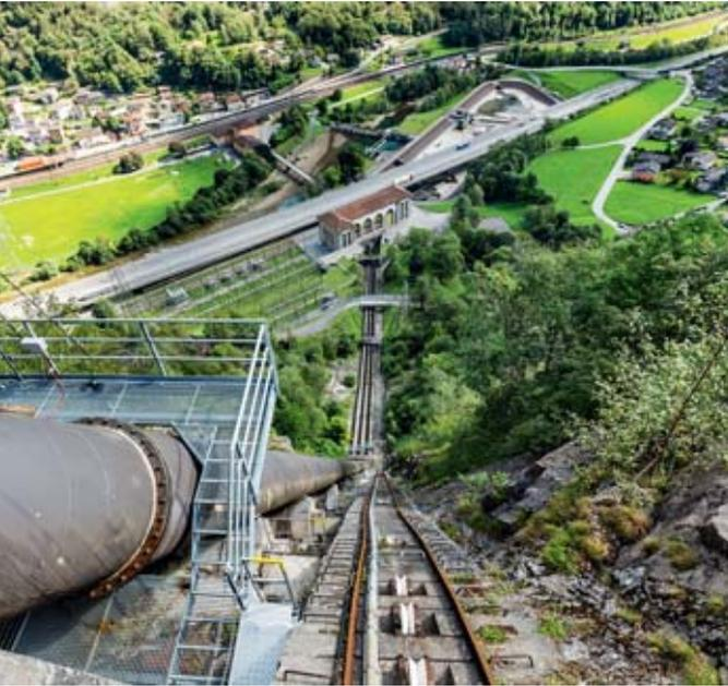
Noch steiler geht kaum: die Druckleitungen, die ins Tal führen.
