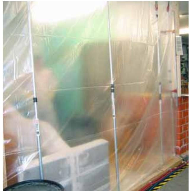
**Figure 4:** Séparation en zone noire et en zone blanche au moyen d'un film plastique.
