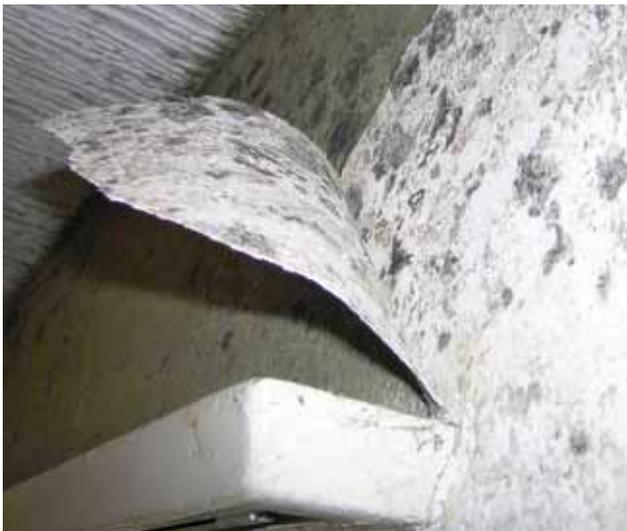
**Figure 2:** Contamination par des moisissures sur le et le crépi se trouvant en dessous (contamination des couches sous-jacentes).
