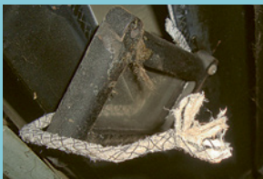
Corde di amianto
