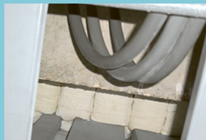
Barriere antifiamma con cuscini di amianto
