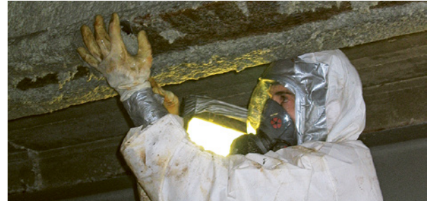
Rimozione solo da parte di ditte specializzate in bonifiche da amianto riconosciute
