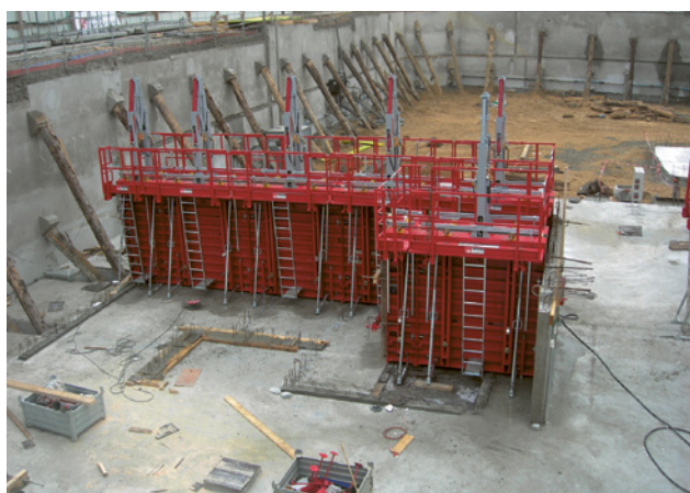
3 Casseratura per pareti con piattaforme di lavoro su entrambi i lati
