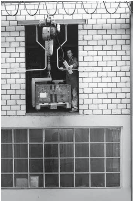
Bild 4: Wandöffnung für Transport mit Hebezeug. Das Geländer verläuft nicht durchgehend. Dadurch ist eine ungehinderte Durchfahrt des Hebezeugs möglich.
