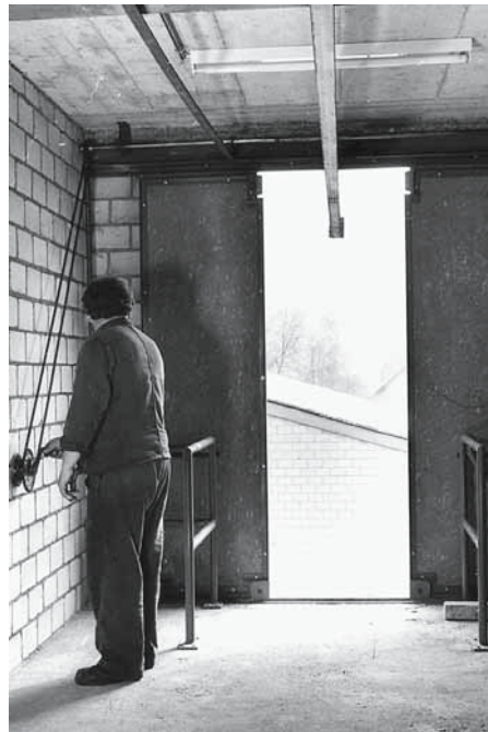
Bilder 5 und 6: Wandöffnung für Warenumschlag mit Hebezeug über Laufschiene ins Freie. Die abgebildete Schiebetüre lässt sich aus einer gewissen Entfernung gefahrlos öffnen und schliessen. Auch das Bedienen des Hebezeugs und die Verständigung mit dem Lastanbinder auf der unteren Ebene ist von einem sicheren Standort aus möglich.
